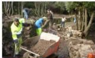
Stage murets en pierres sèches: Salariés de l'Amichi et de l'Entreprise SMTF
